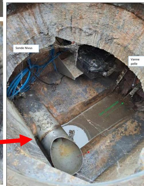
Arrivée - Point A2 - réseau d'eaux pluviales, équipé d'une sonde hauteur/vitesse de marque Nivus, arrivée en surverse
